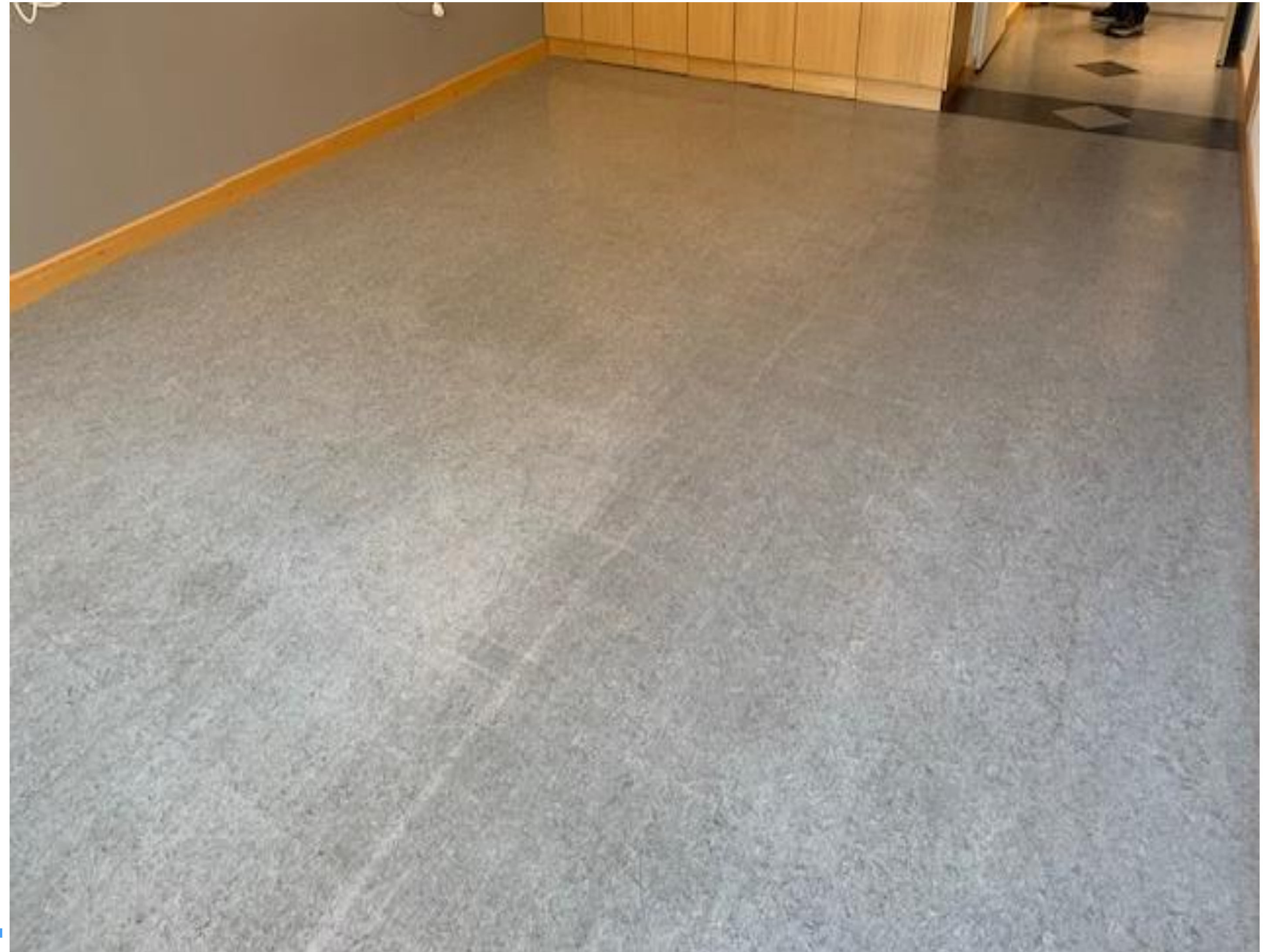
Linoleum vor der Grundreinigung
