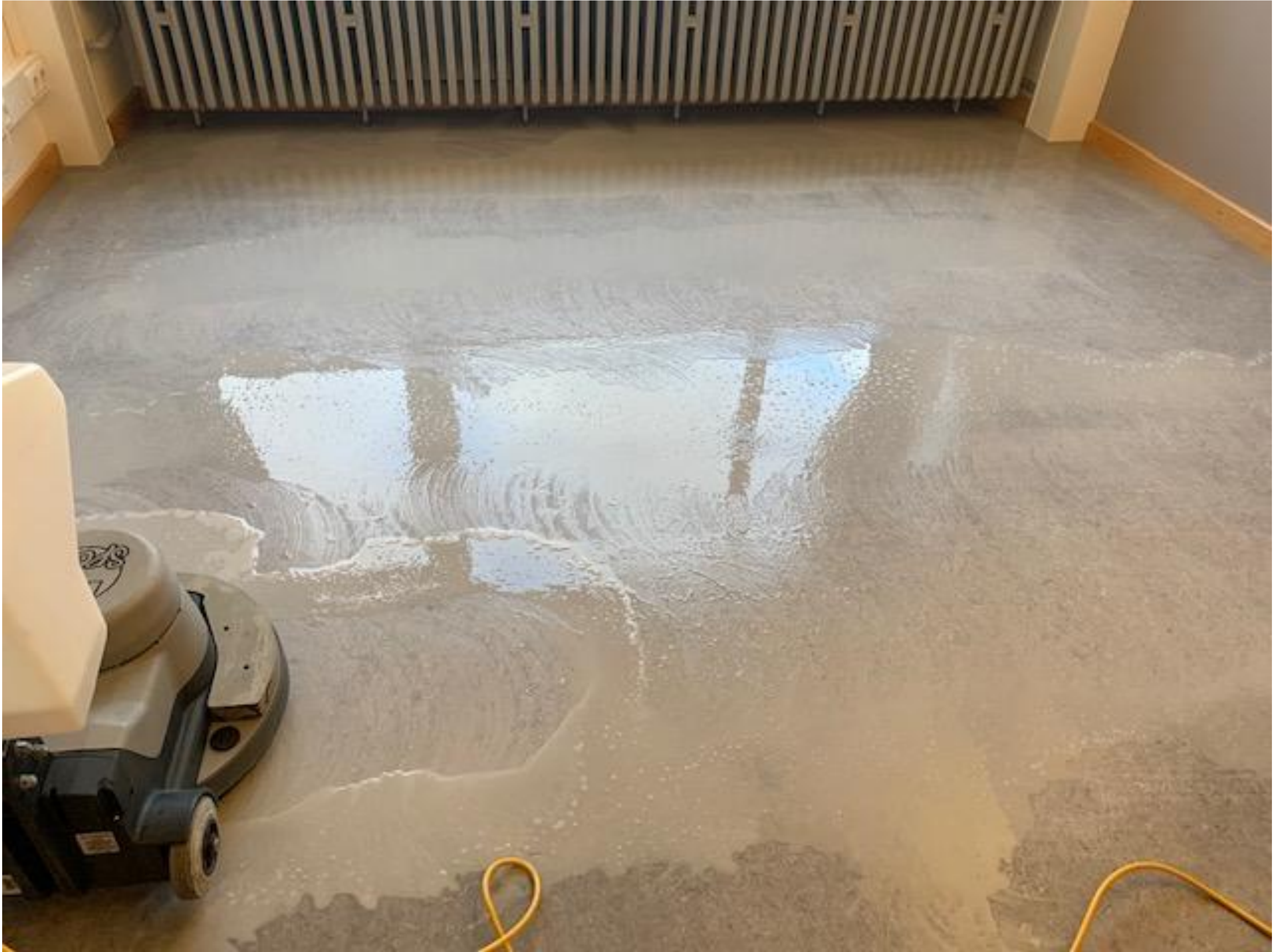
Grundreinigung des Linoleumbelages
